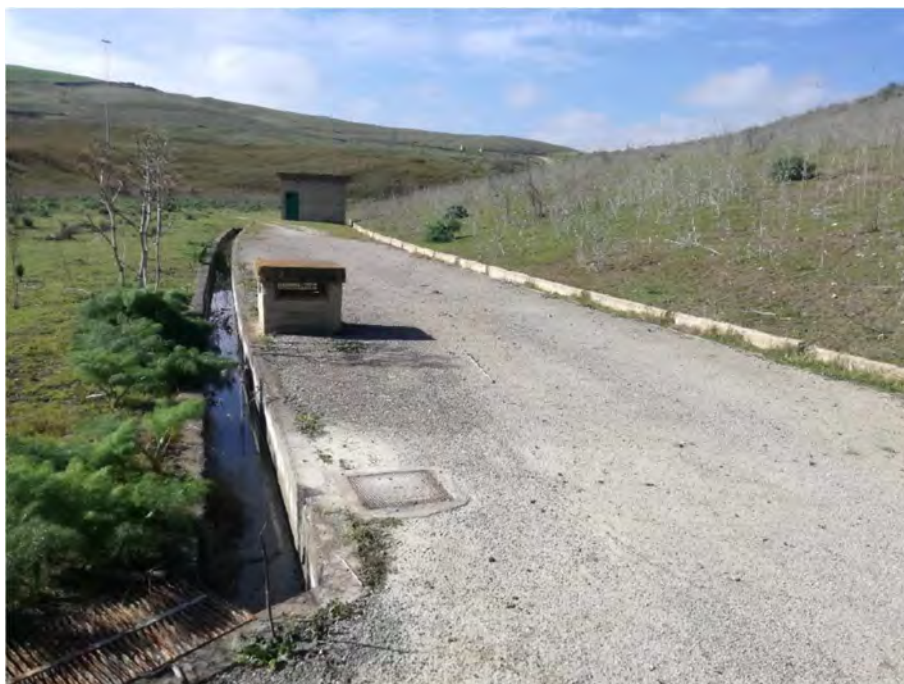
Figura 7.1: Diga di Gibbesi – Torre di drenaggio con in primo piano il torrino di ventilazione Est
