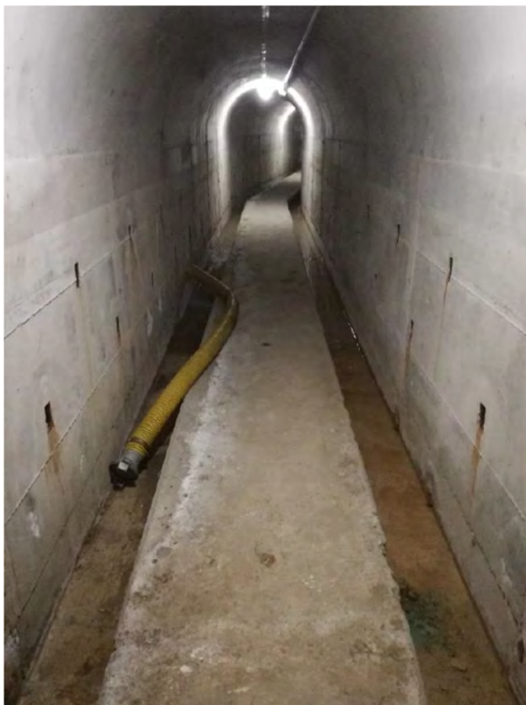
Figura 7.4: Diga di Gibbesi – Cunicolo drenaggio Ovest
