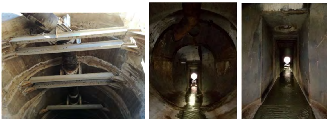
Figura 6.1: Diga di Gibbesi – Gallerie di scarico: concrezioni e macchie presenti sulla superficie interna
