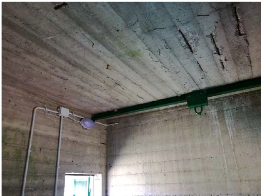
Figura 7.2: Diga di Gibbesi – Solaio di copertura - armature ossidate con particolare del gancio di sollevamento pompe acque cariche
